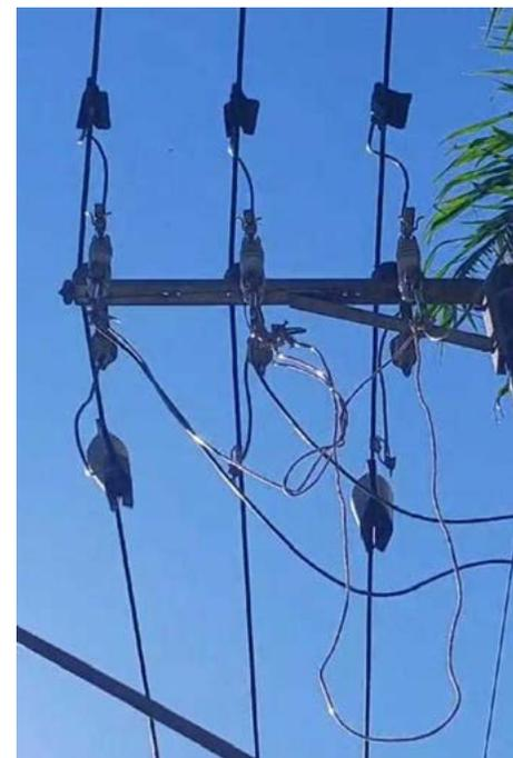
de do aterramento que deveria se conectar ao neutro não foi instalada, o que seria o procedimento correto. Além disso, não foi instalada placa de sinalização.
