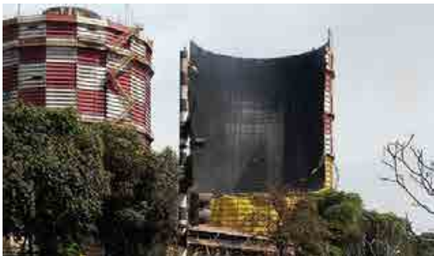
Local da explosão na Usiminas - Foto: Divulgação Web
